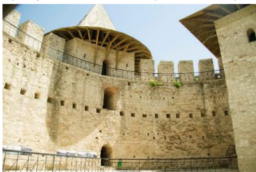
Acoperișurile Cetății Soroca: structură din lemn ce constă dintr-o urzeală de grinzi acoperite cu țigle din lemn
