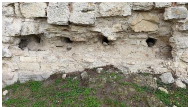
Prăbușirea și pierderea locală a pietrei de parament în spațiul gol lăsat de braul din lemn pierdută
