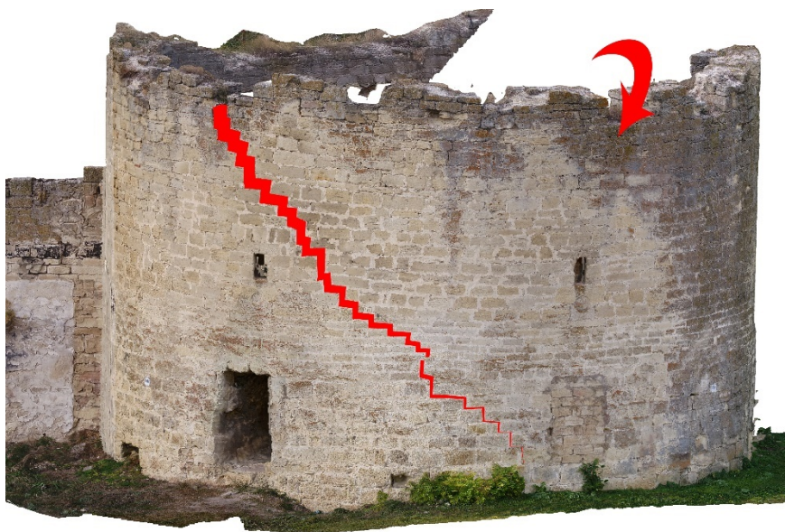
Mișcări cinematice tipice ale porțiunii zidăriei în cazul unor clădiri circulare, cum ar fi Turnul B3
