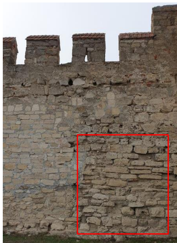
Pierdere de rosturi, degradarea pietrei de parament, pierderea de pietre
