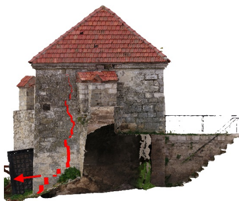
Rotația la baza peretelui din cauza surpării terenului
