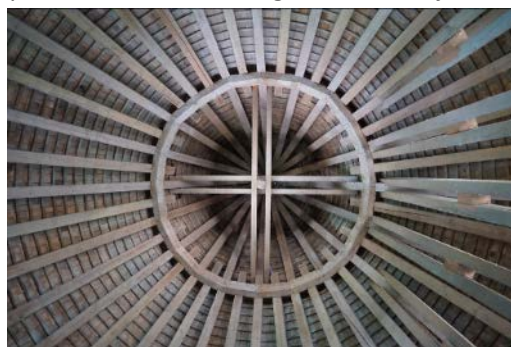
Acoperișurile Cetății Soroca: structură din lemn ce constă dintr-o urzeală de grinzi acoperite cu țigle din lemn
