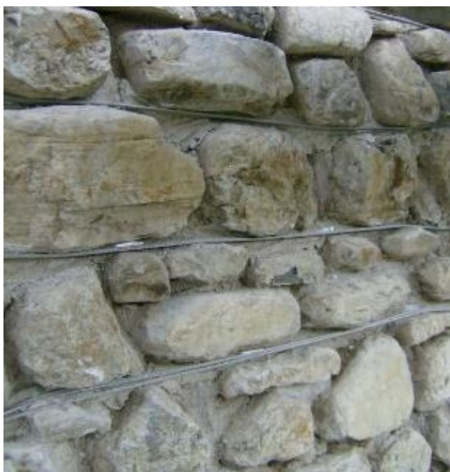
Toroanele din oțel inserate înăuntru rosturilor din mortar și rosturile după intervenția propusă.
